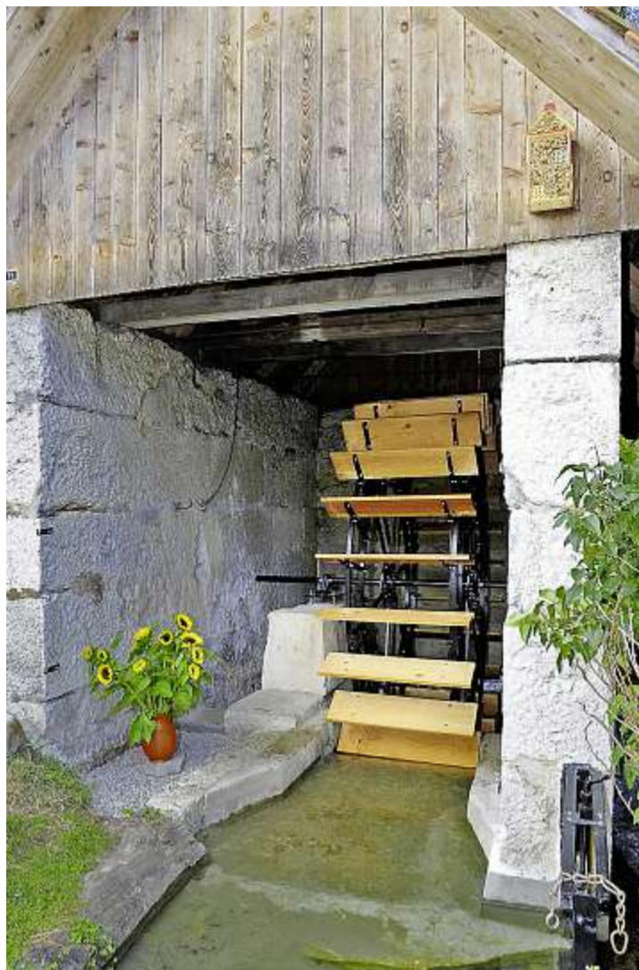
Altes Gebäude, neues Wasserrad: Radwerklandshut hat der Anlage beim Bären Utzenstorf zu neuem Glanz verholfen.
